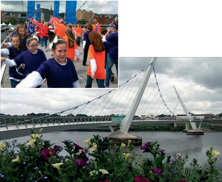
312 Meter lang und 14,6 Mio. Euro teuer: Derrys Brücke über den Foyle
