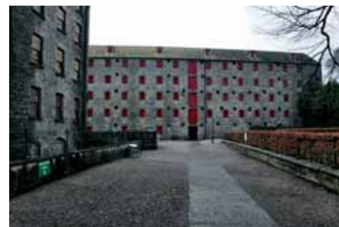
Die ehemaligen Grain Lofts
