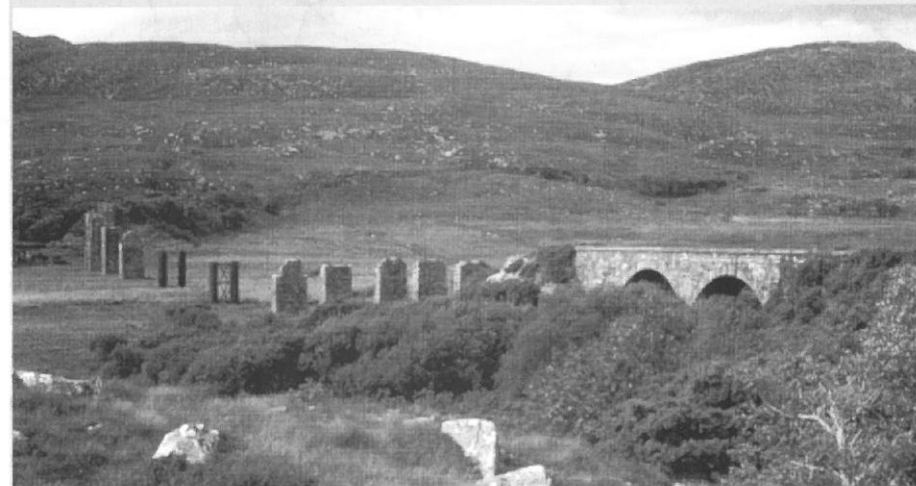
Überreste des Owencarrow Viadukts
