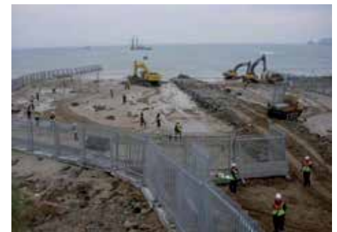
Oben: Broadhavenbay, unten: Shell Baustelle
